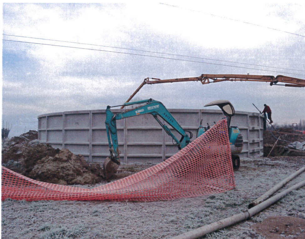
Vasca circolare durante l'esecuzione di alcune opere
