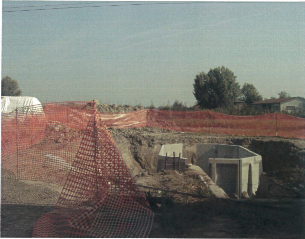
vasca ottagonale durante la sua esecuzione
