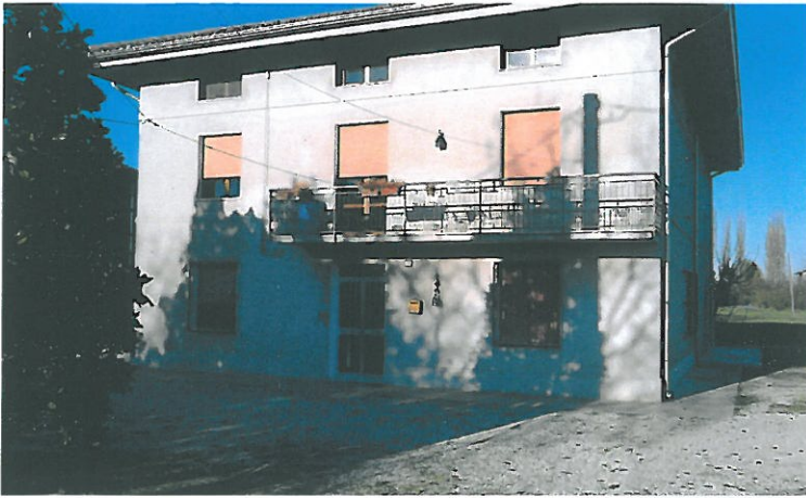
Facciata sud abitazione
