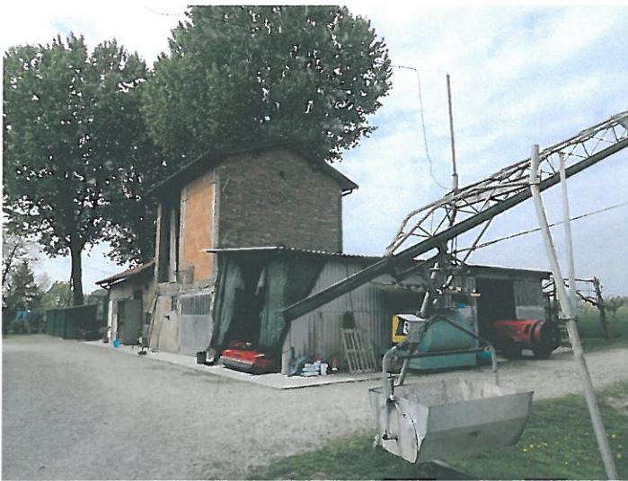
Bassi servizi in demolizione
