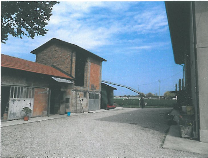
Bassi servizi in demolizione
