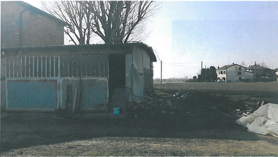
Lato nord e ovest del basso servizio in demolizione
