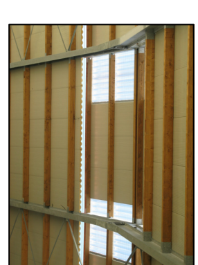
TRAVE IN FERRO ROMPISTATA IN LEGNO
