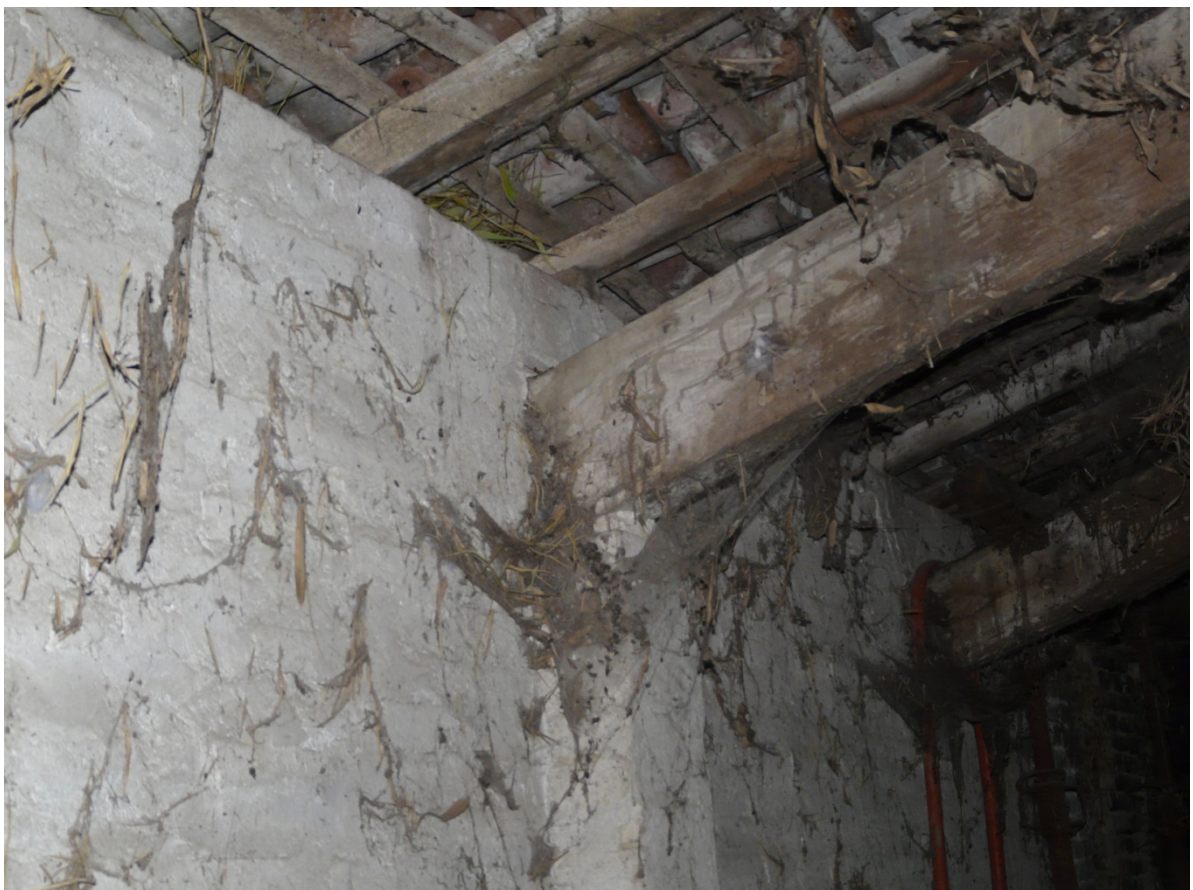
Particolare della base del pilastro, che non poggia a terra, e dell'appoggio della trave
