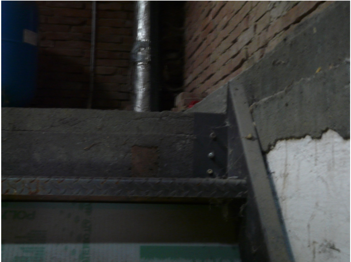
Particolare della soletta, dell'attacco della scala alla trave e del cordolo postumo
