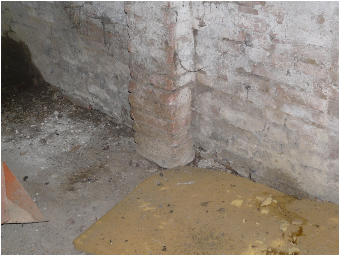
Particolare della base del pilastro, che non poggia a terra, e dell'appoggio della trave
