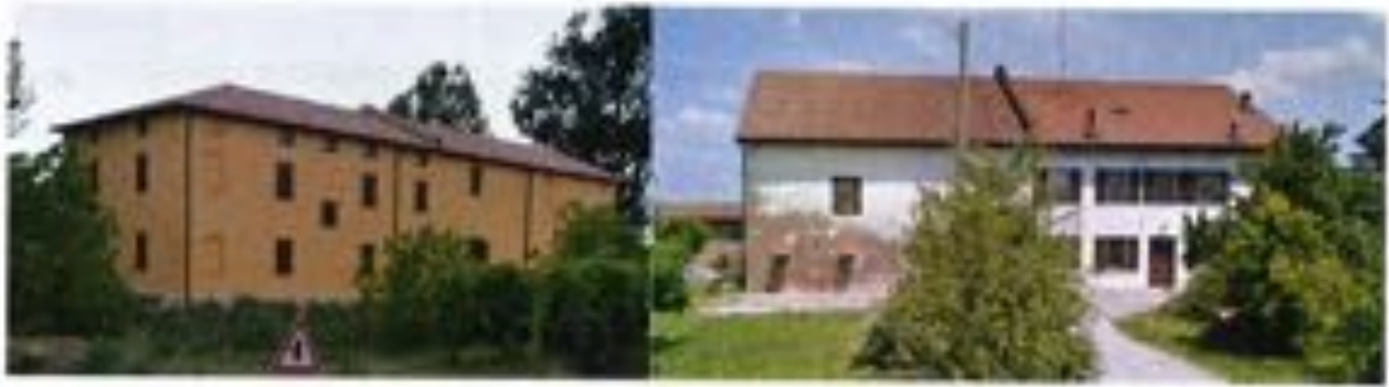
Sopra alcuni esempi di fabbricati con aletta frangi fuoco del territorio rurale.
