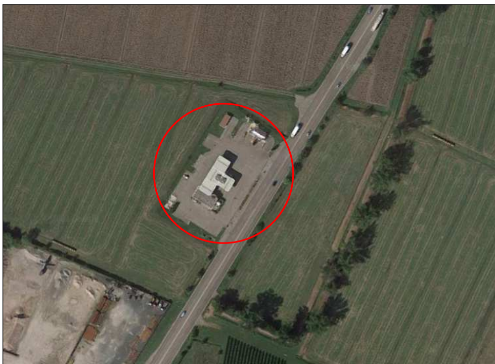
Vista zenitale dell'area di servizio
