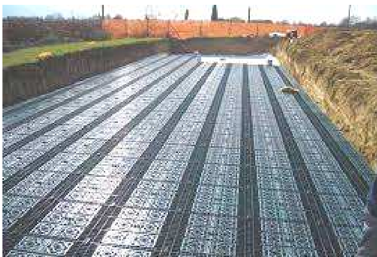
Esempio di posa di elementi modulari tipo "RigoFill ST"
